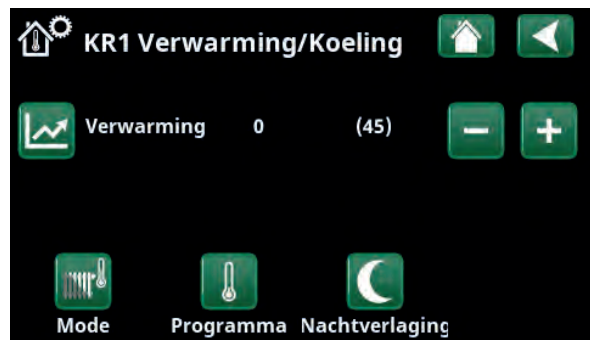
Menu "Installateur/Definieer/Verwarmingskring/Verwarmingskring 1". De verwarmingskring heeft geen ruimtevoeler, het setpoint staat tussen haakjes (vertrektemperatuur 45°C). Links van het setpoint staat de buitentemperatuur (0°C) bij de huidige vertrektemperatuur.
