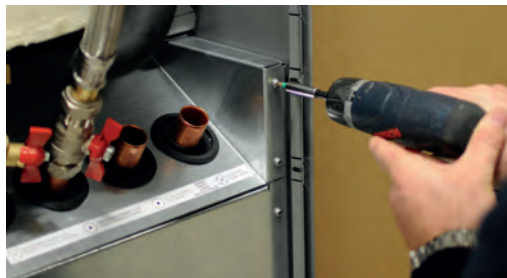
3. Draai de schroeven van de koelmodule los.
