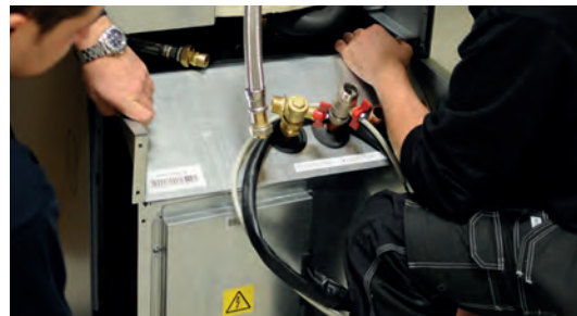
5. Trek aan de koelmodule door de voorste rand eerst iets op te tillen met de draaggrepen.
