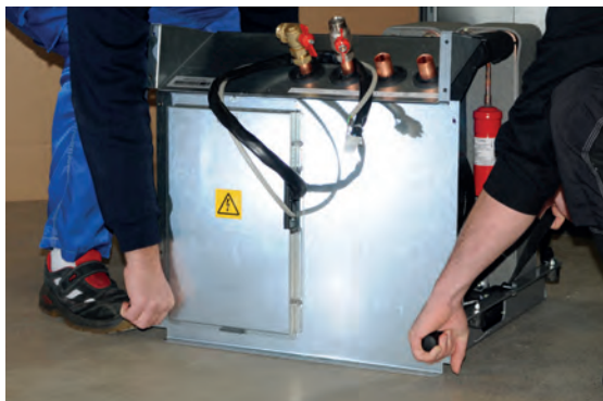
6. Til de koelmodule op met de draaggrepen en de schouderbanden.
